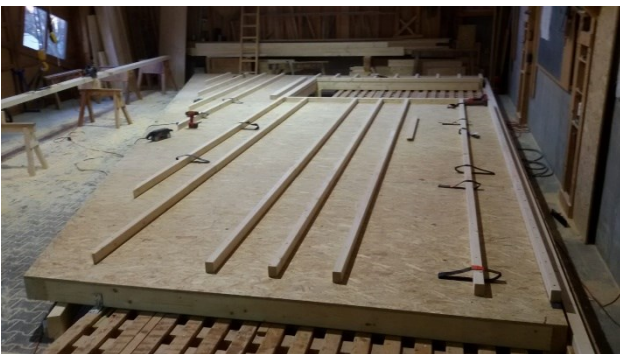
Ein vormontiertes Wandteil mit Tür und Dachschräge.
