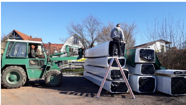
Abladen der Dachteile mit dem Radlader.
