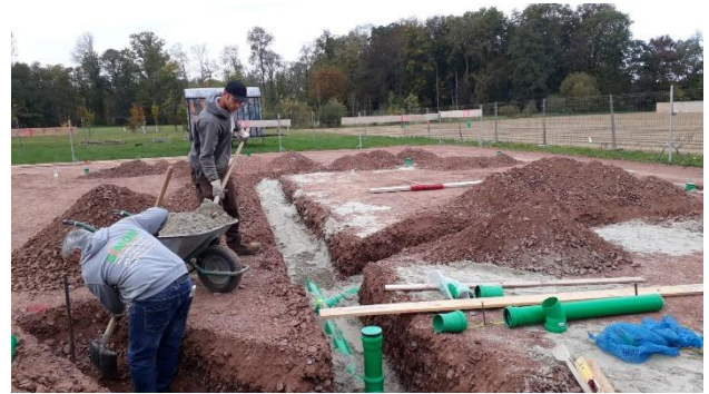
Verlegen der Abwasserrohre
