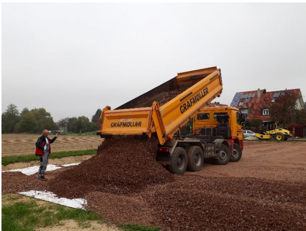
Schotter wird aufgefüllt und festgewalzt
