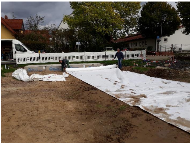
Lange Vliesbahnen werden verlegt
