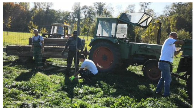
Mit vereinten Kräften wird das komplette Grundstück eingezäunt
