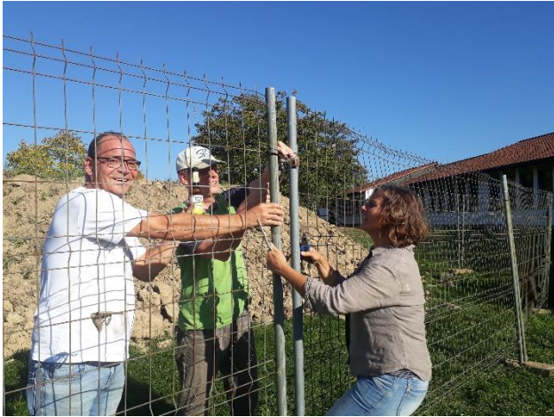
Noch ein paar Befestigungen und alles steht
