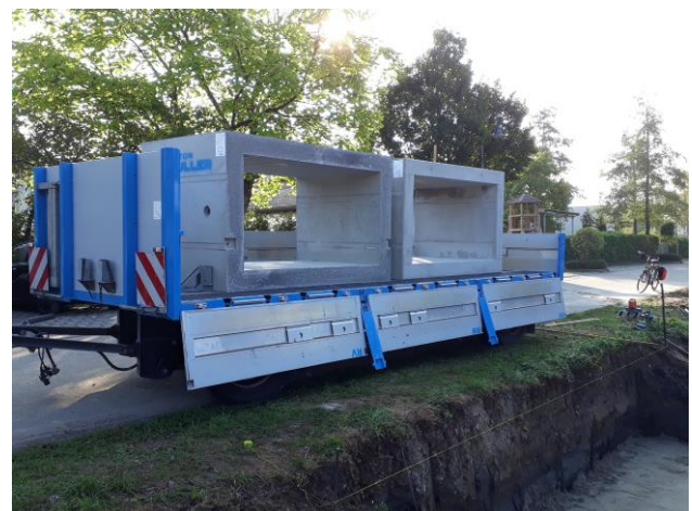
Die Brückenbauteile werden geliefert...
