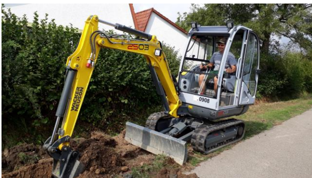
Tobias Winkler baggert den Graben aus.
