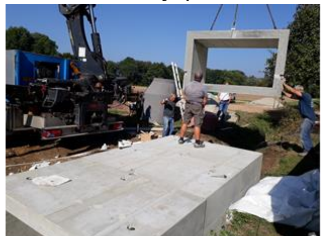
... und in den vorbereiteten Graben eingelassen.
