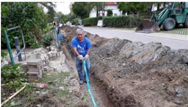
Die Leitungen werden im Graben verlegt.
