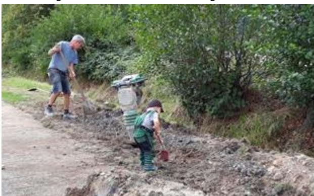
Winkler Junior beaufsichtigt die Erdarbeiten.
