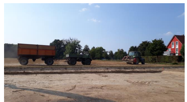
Meinhard und Matthias heben zusammen mit Herrn Hug die Baugrube aus.
