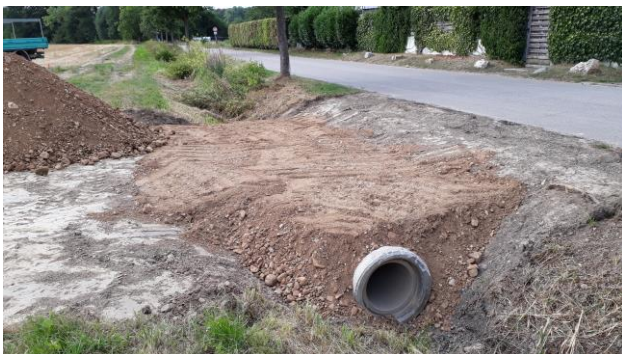
Anlieferung der Rohre und Bau der Behelfsbrücke.
