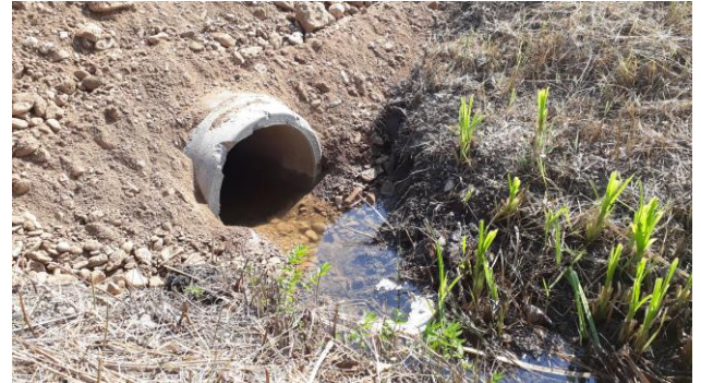
Kaum sind die Rohre gelegt, führt der Katzenbach wieder Wasser.
