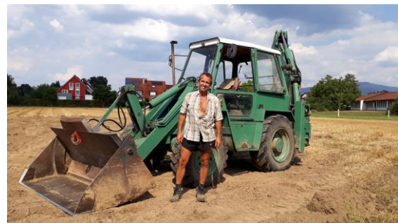
Vorbereitungen zum Abkippen des Erdaushubes
