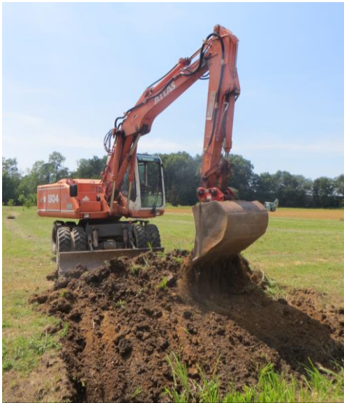
Der große Bagger der Firma Hug ist am Werk
